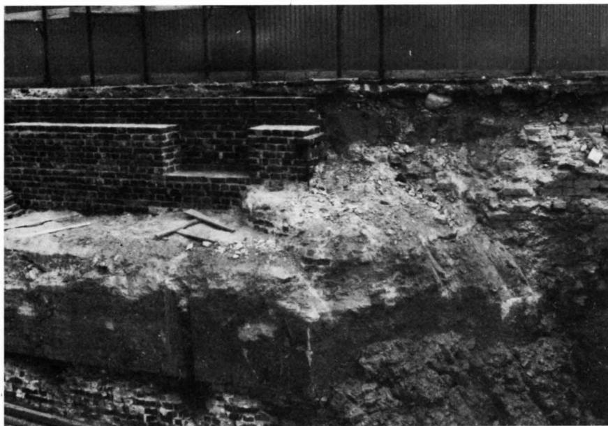
Foto 4 - Opera muraria medioevale: estremità ovest - veduta d'insieme della pila rostrata.
