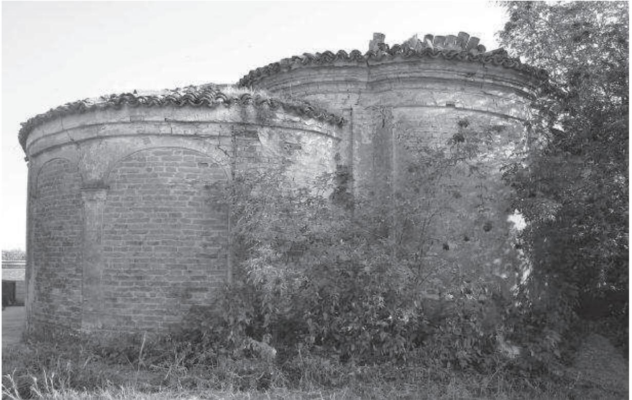
Figura 29. – Nel lato rivolto a nord è ben visibile il volume curvilineo della cappella. La copertura abbisogna di urgente riparazione per evitare danni alla volta.
