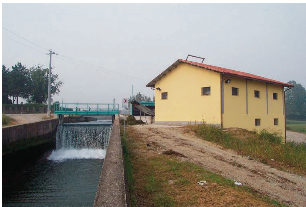
Figura 3. La centrale sul canale Scolmatore di Genivolta.
