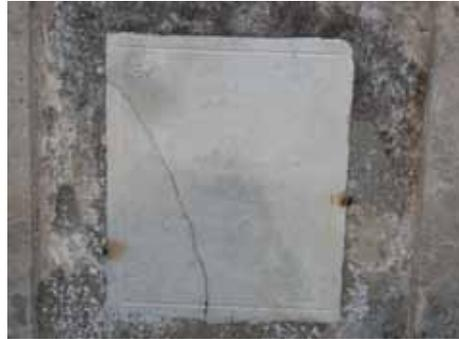
3. Lapide in stato di estremo degrado a causa degli agenti atmosferici
