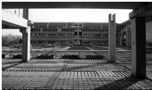
Vista dalla corte del blocco aule
