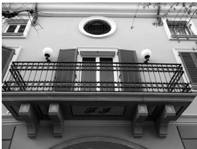
Particolare di edificio contemporaneo “nuovo-antico”
