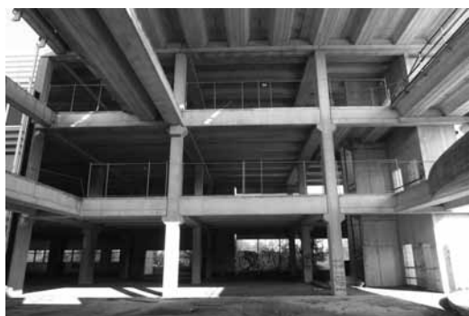
Vista dall'ingresso del primo blocco aule
