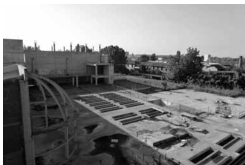
Vista della corte interna del complesso
