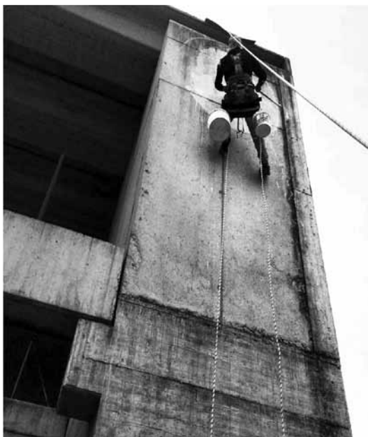
Realizzazione dell'ombellico bifaccia
