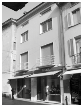
Edifici degli anni 60 del 900 chiaramente individuabili all'interno del tessuto storico
