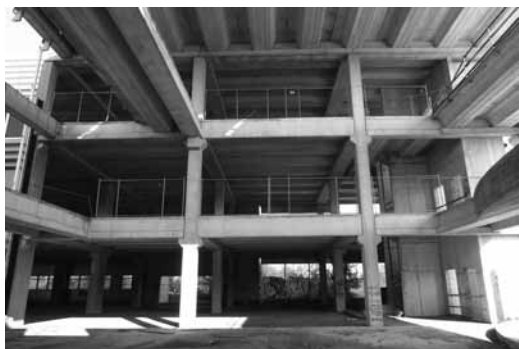
Vista dall'ingresso del primo blocco aule
