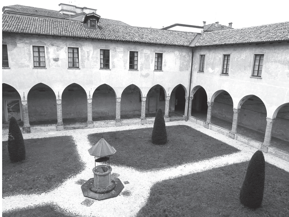
Crema, Ex convento di S. Agostino, veduta generale del secondo chiostro.
