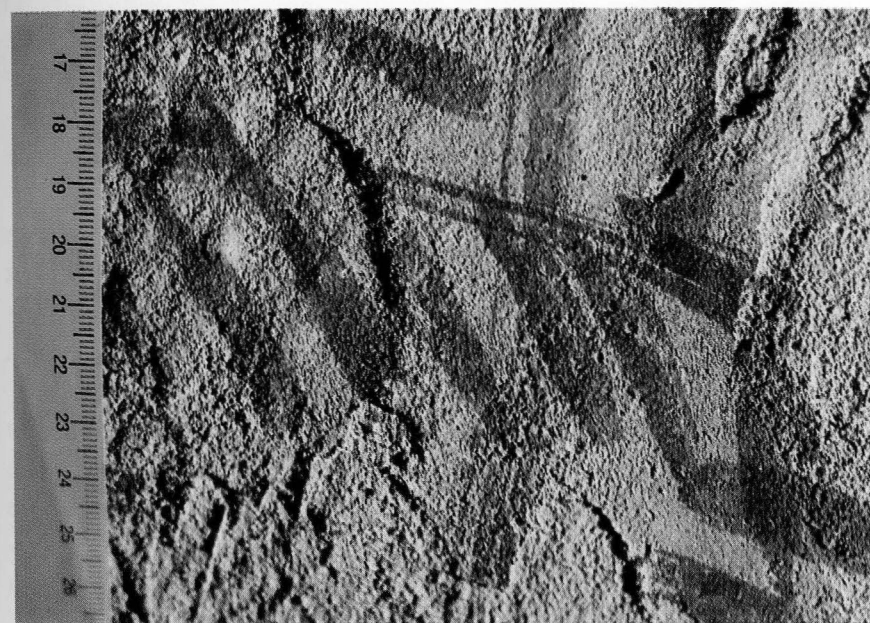
Fot. 2 a, b. Crema. Depositi del Museo Civico, già nel refettorio del convento di sant'Agostino. Macrofotografie a luce radente degli intonaci d'arriccio della sinopia della Crocifissione (a), e dell' Ultima cena (b), che evidenziano la smaltatura con una cazzuola a lama larga usata di piano, senza ulteriori compressioni o lisciature.
